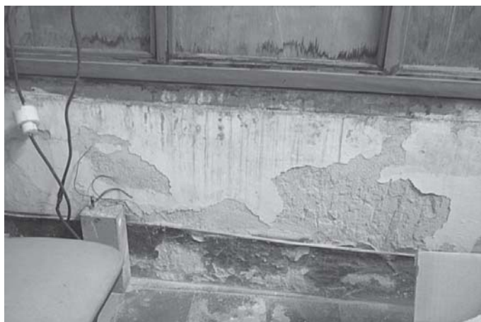
Muestras de humedad en las paredes.
