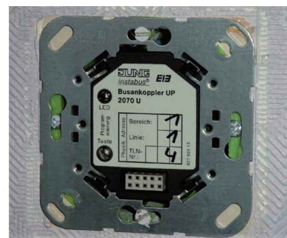
Figura 6.11. Acoplador de bus para un elemento instalado en cajetín (caja de empotrar), sobre el que se ha marcado su dirección física. Cortesía de la Asociación KNX.
