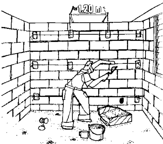
Fig. 2.K Puntos para Maestras Interiores.
