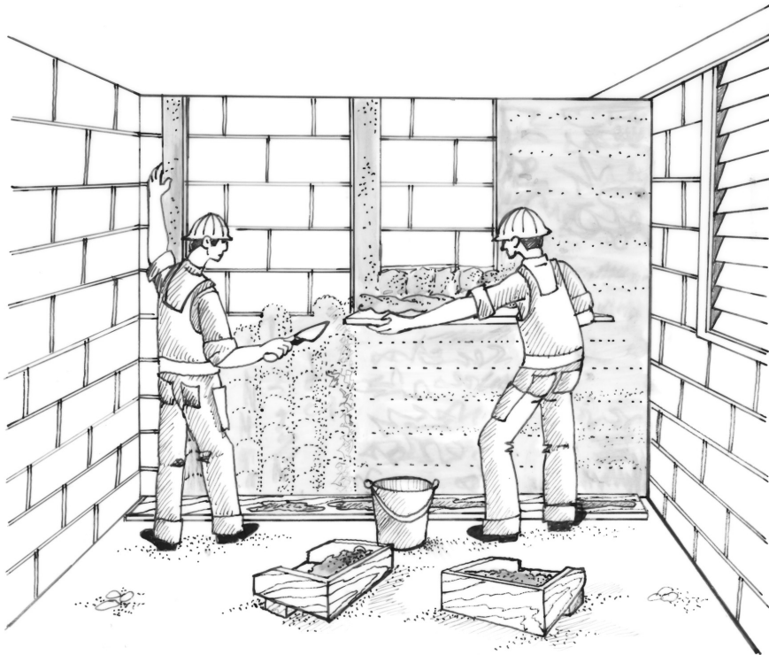
Fig. 3.10 Revestimiento de paredes
