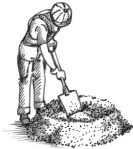
Fig. 3.1 Elaboración manual (arena y cemento)
