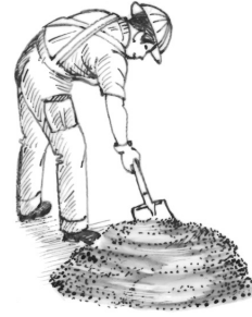
Fig. 3.3 Elaboración manual de los componentes del mortero
